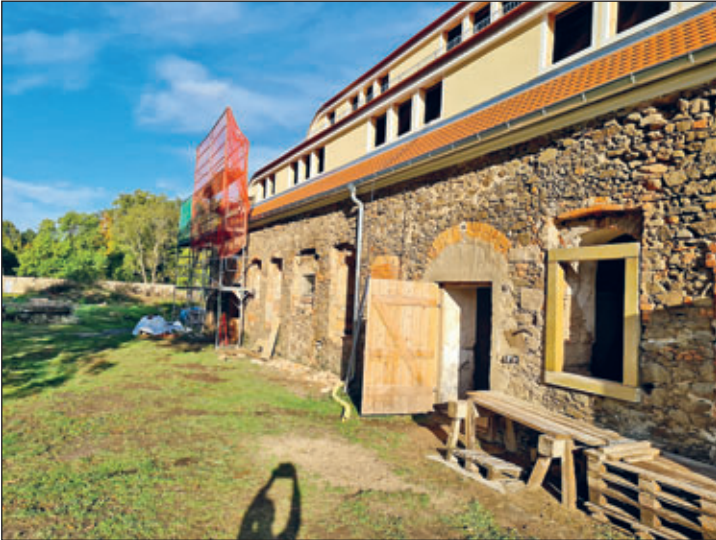
Beginn Einbau neuer Fenster- und Türgewände Haus 1
