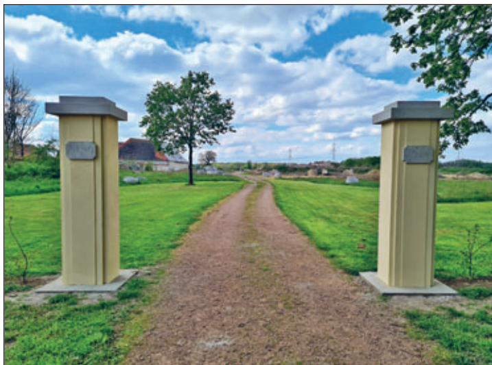
Künftiger Eingangsbereich zur Ferienhaussiedlung
