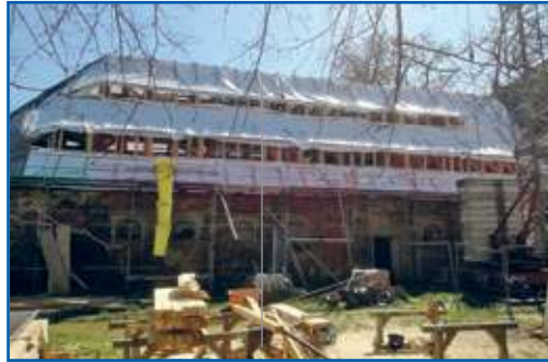
Baugeschehen am Dachstuhl des ehemaligen Pferdestalls
