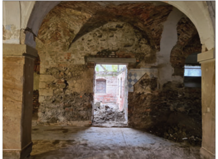
Neuer Durchgang von Restaurant zur Küche
