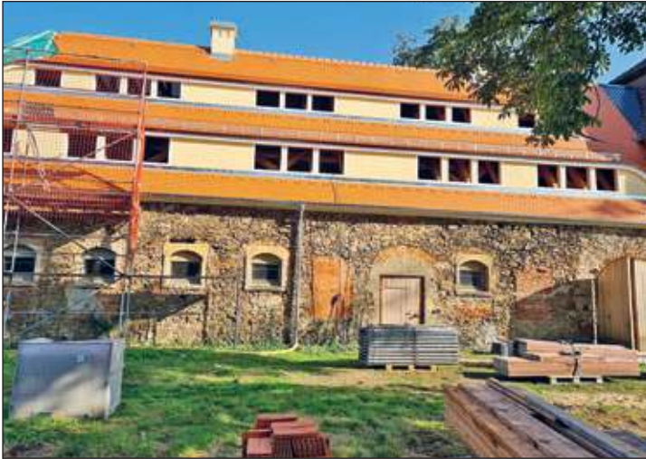
Dacheindeckung ehemaliger Pferdestall
