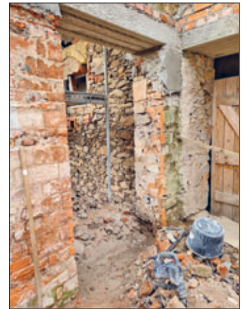
Durchbruch Küche - Außenterrasse
