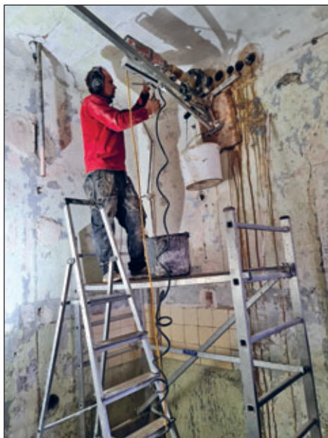
Kernbohrarbeiten im Haus 2
