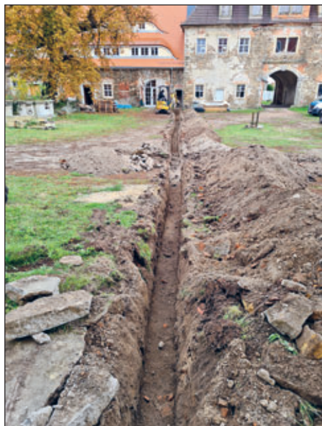
Aushub auf dem Schlosshof – Leerrohrverlegung Serverdatenkabel
