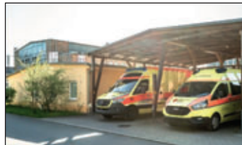
Haus 5 – Am Stahlwerk 11 DRK Rettungswache
