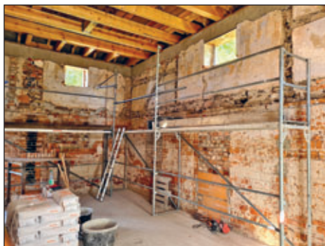
Maurerarbeiten künftige Restaurantküche
