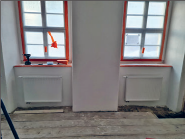
Erste Heizkörper sind montiert
