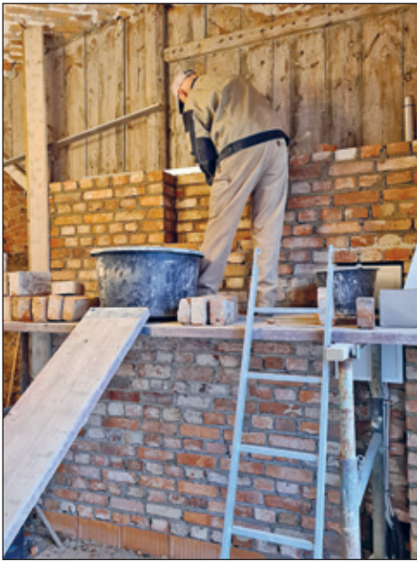
Maurerarbeiten im Haus 1
