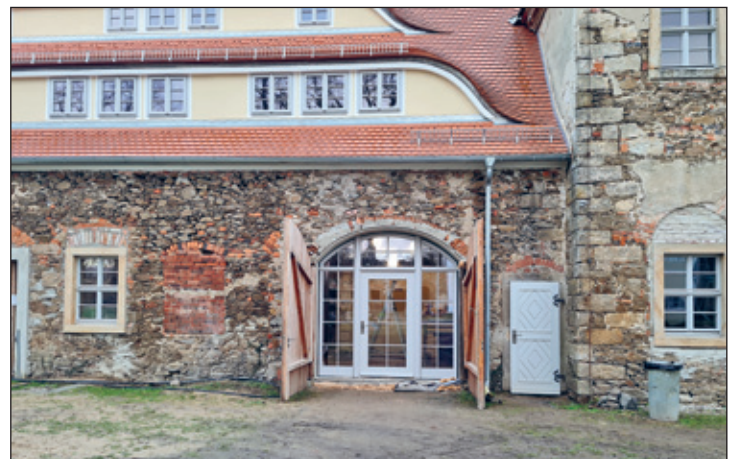
Neues Glastor zur WC-Anlage
