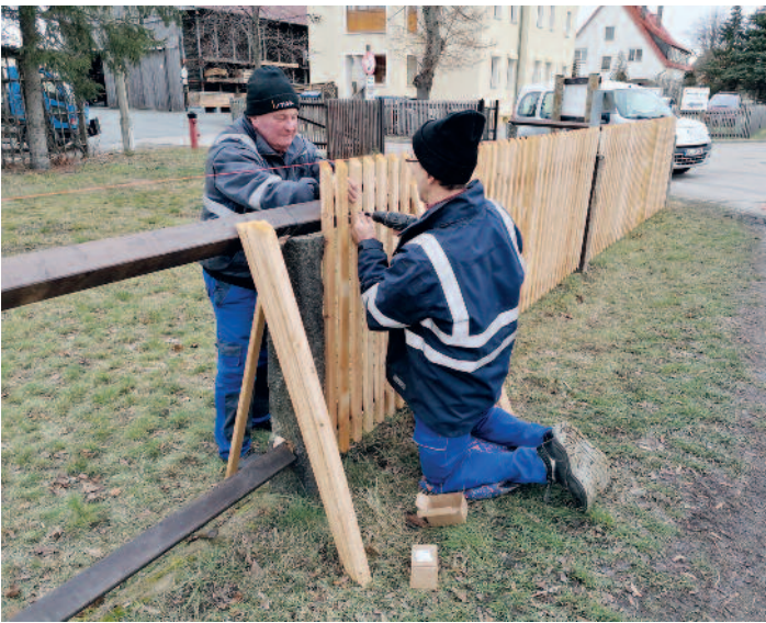
Zaunbau am Imprägnierwerk.
