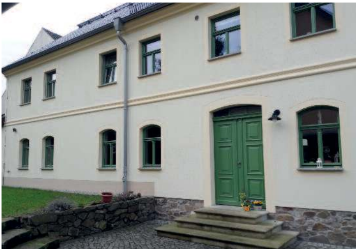
An Umgebung angepasster Ersatzneubau – Hof Familie Gutmann in Peritz – unter Beachtung einer klaren Fassadengliederung mit Fenstersprossung.
