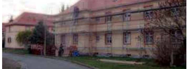
Sanierung der Siedlung durch Fa. Rühle & Rose schreitet voran
