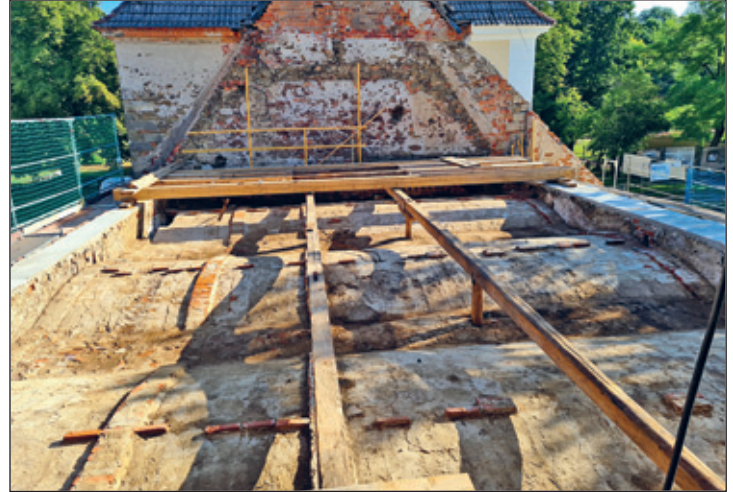
Freilegung Gewölbedecke Haus 3
