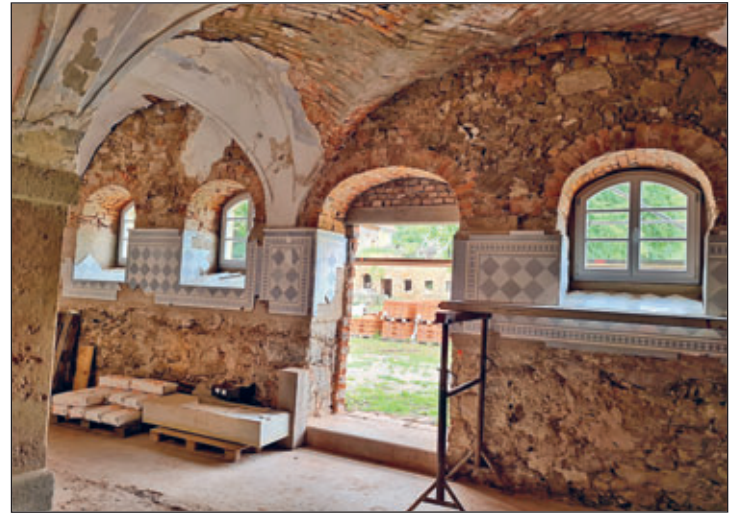
Neue Fenster im Haus
