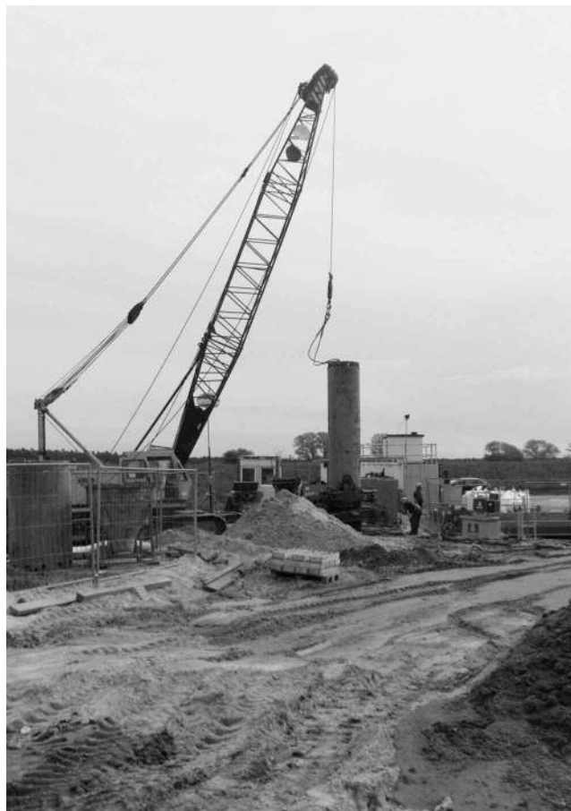
Ein Seilbagger im Einsatz bei den Kies austauschbohrungen.
