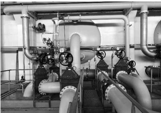
Die Filterarmaturen im Wasserwerk Fichtenberg werden erneuert.
