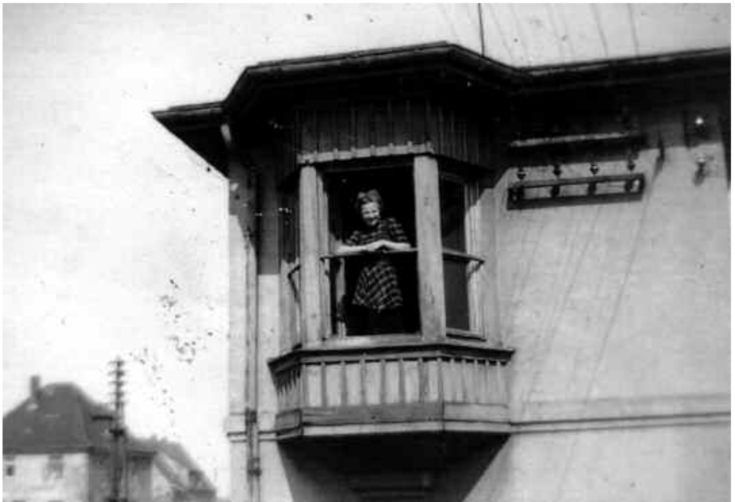
Frau Hausmann im alten Stellwerk an der Lichtenseer Straße.
