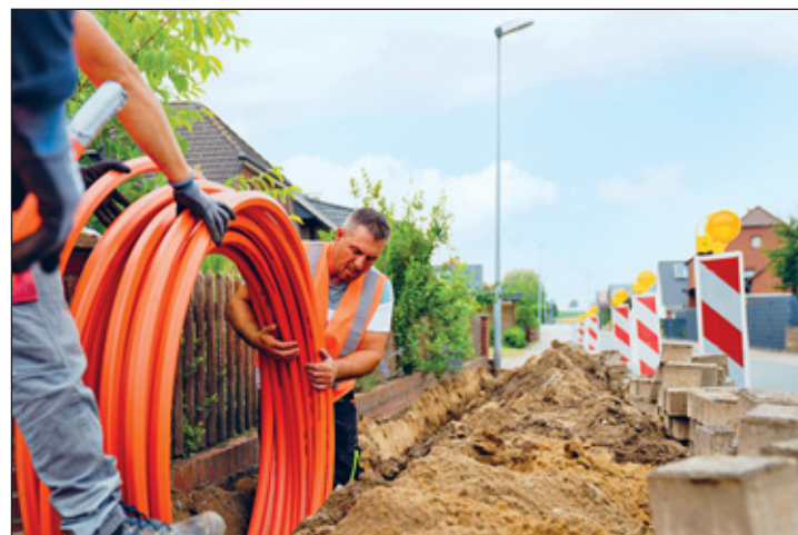
Symbolfoto Glasfaserausbau. Foto: Deutsche Glasfaser
