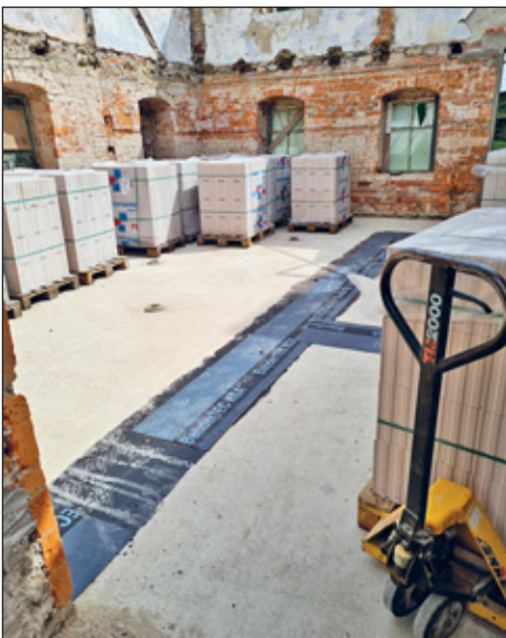
Beginn Maurerarbeiten Treppenhange
