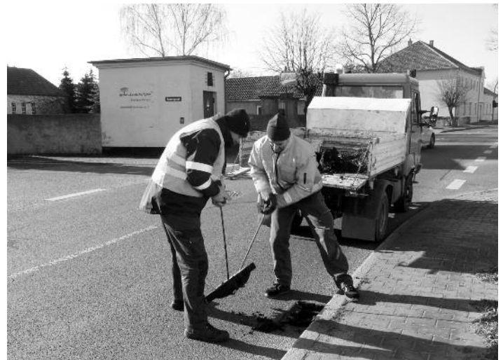
Reinigung Straßeneinläufe – B 169 in Lichtensee.
