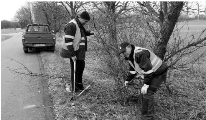
Lichtprofil an kommunalen Straßen herstellen – hier Heidehäuser Weg – Verkehrssicherheitspflichten.
