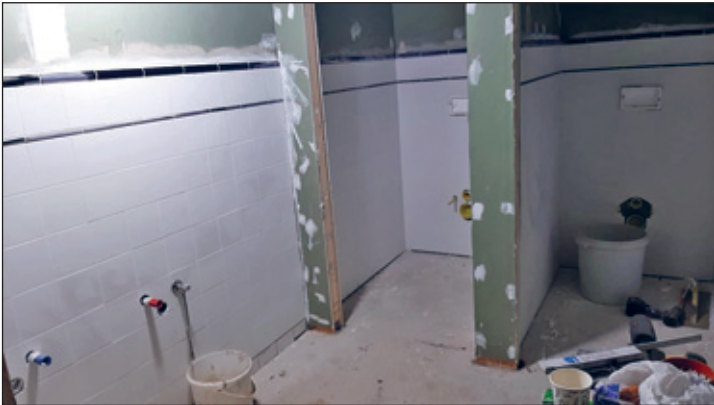
Innenausbau WC-Anlage Haus 1
