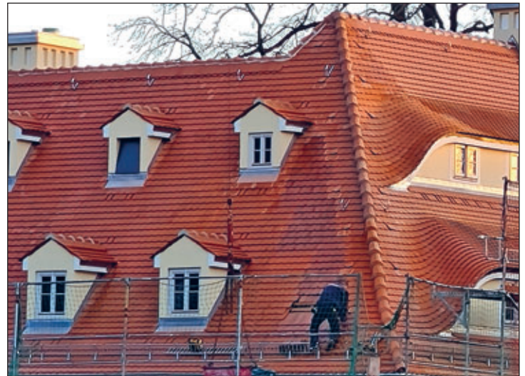
Fertigstellung Dacheindeckung Haus 1
